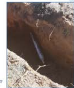
Fouçage : technique de traversée sous chaussée
